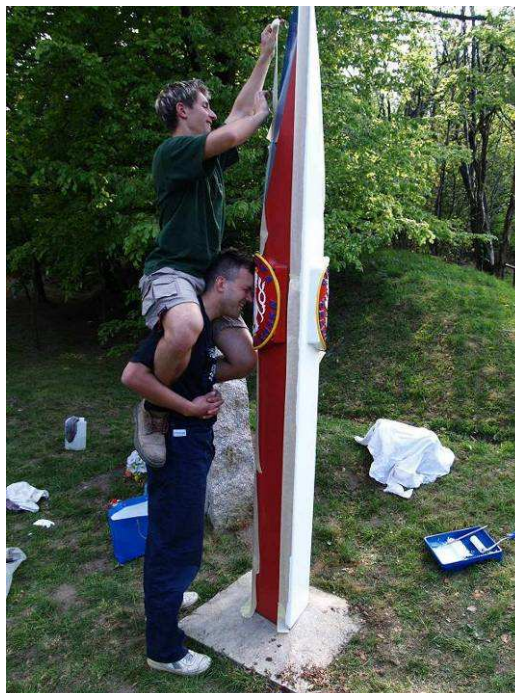
Příprava na opravu bílého nátěru sloupu.
